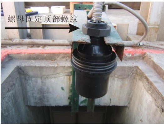
①在探头顶部螺纹用螺母固定
